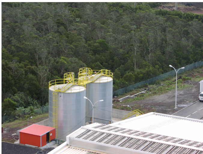
Figura 3. Tanques de Amónia
